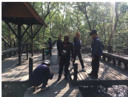
งานปรับปรุง สะพานเดินชม ป่าชายเลน
