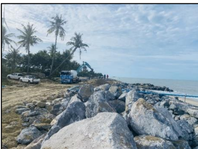
ภาพที่ ๓ ภาพแสดงการดำเนินการก่อสร้างเขื่อนป้องกันตลิ่งริมทะเล ของกรมโยธาธิการและผังเมือง พื้นที่หมู่ที่ ๕-๖ ตำบลหน้าสตน อำเภอดุสิต จังหวัดนครราชสีมา
