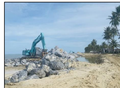
ภาพที่ ๓ ภาพแสดงการดำเนินการก่อสร้างเขื่อนป้องกันตลิ่งริมทะเล ของกรมโยธาธิการและผังเมือง พื้นที่หมู่ที่ ๕-๖ ตำบลหน้าสตน อำเภอดุสิต จังหวัดนครราชสีมา
