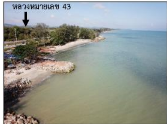
รูปที่ ๔-๘ รูปภาพแสดงการกัดเซาะชายฝั่งจากโครงสร้างเขื่อนหินทิ้งริมชายฝั่ง และรอดักทราย ของชาวทองรีสอร์ท
