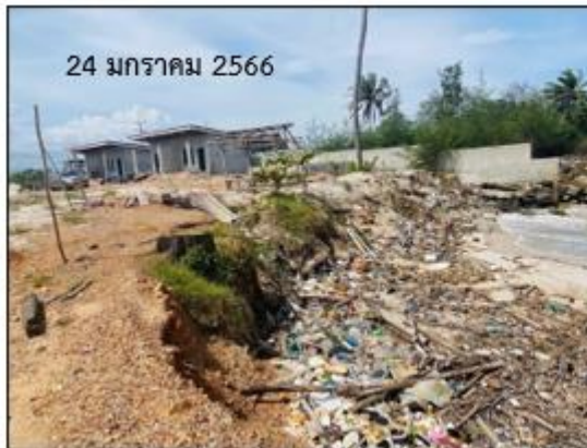
รูปที่ ๔-๑๐ รูปภาพแสดงการกัดเซาะชายฝั่งจากโครงสร้างเขื่อนหินทิ้งริมชายฝั่งของไม้สนรีสอร์ท
