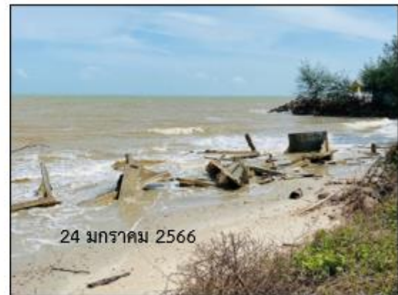
รูปที่ ๔-๙ รูปภาพแสดงการกัดเซาะชายฝั่งจากโครงสร้างเขื่อนหินทิ้งริมชายฝั่ง ของหาดทิพย์ ซีวิว รีสอร์ท
