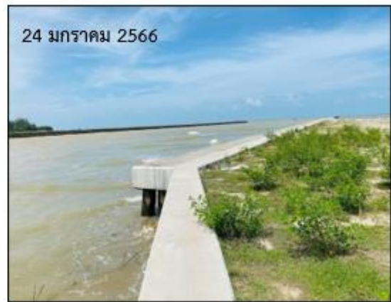
รูปที่ ๔-๗ รูปภาพแสดงร่องรอยการกัดเซาะชายฝั่งจากชุดโครงสร้างปากร่องน้ำเทพา
