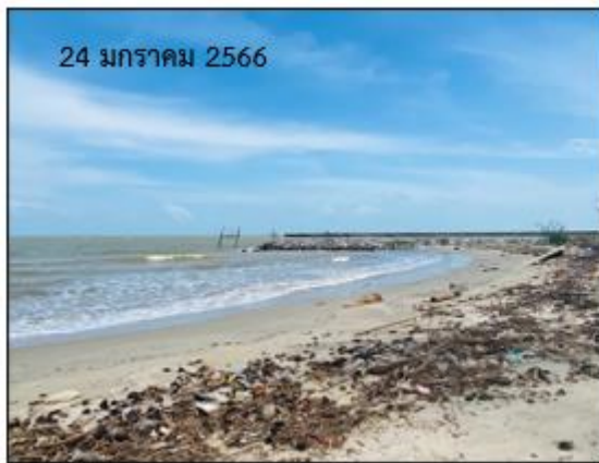
รูปที่ ๔-๗ รูปภาพแสดงร่องรอยการกัดเซาะชายฝั่งจากชุดโครงสร้างปากร่องน้ำเทพา
