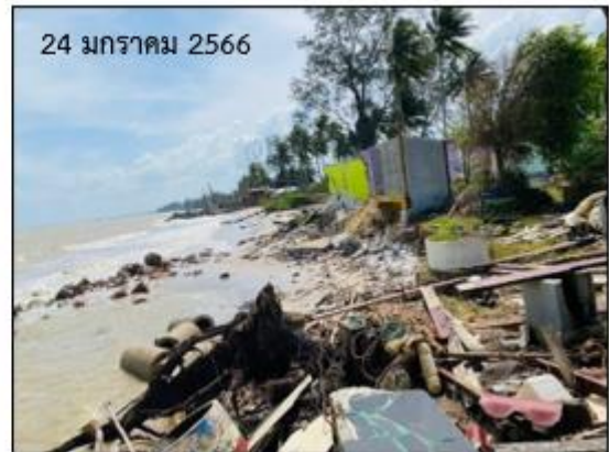
รูปที่ ๔-๑๐ รูปภาพแสดงการกัดเซาะชายฝั่งจากโครงสร้างเขื่อนหินทิ้งริมชายฝั่งของไม้สนรีสอร์ท
