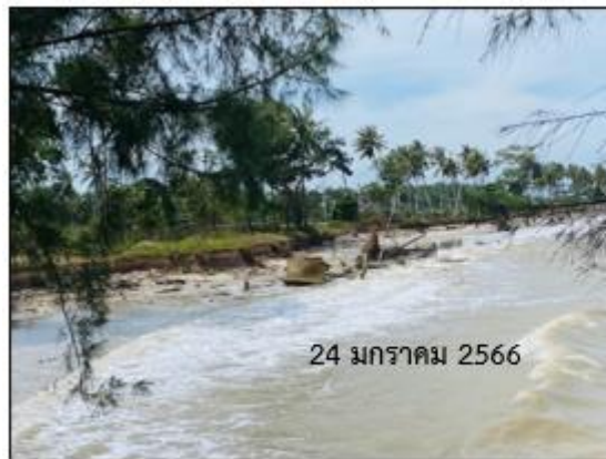
รูปที่ ๔-๙ รูปภาพแสดงการกัดเซาะชายฝั่งจากโครงสร้างเขื่อนหินทิ้งริมชายฝั่ง ของหาดทิพย์ ซีวิว รีสอร์ท
