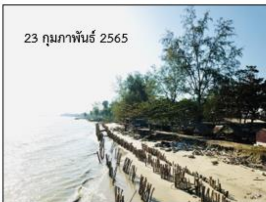
รูปที่ ๔-๑๑ รูปภาพแสดงการนำปักไม้บริเวณชายฝั่งเป็นการชั่วคราว เพื่อป้องกันการกัดเซาะชายฝั่งพื้นที่ ของผู้ประกอบการร้านอาหาร
